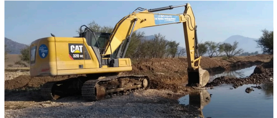
Actualmente se está trabajando en el desazolve del río Mascota, para prevenir inundaciones.
